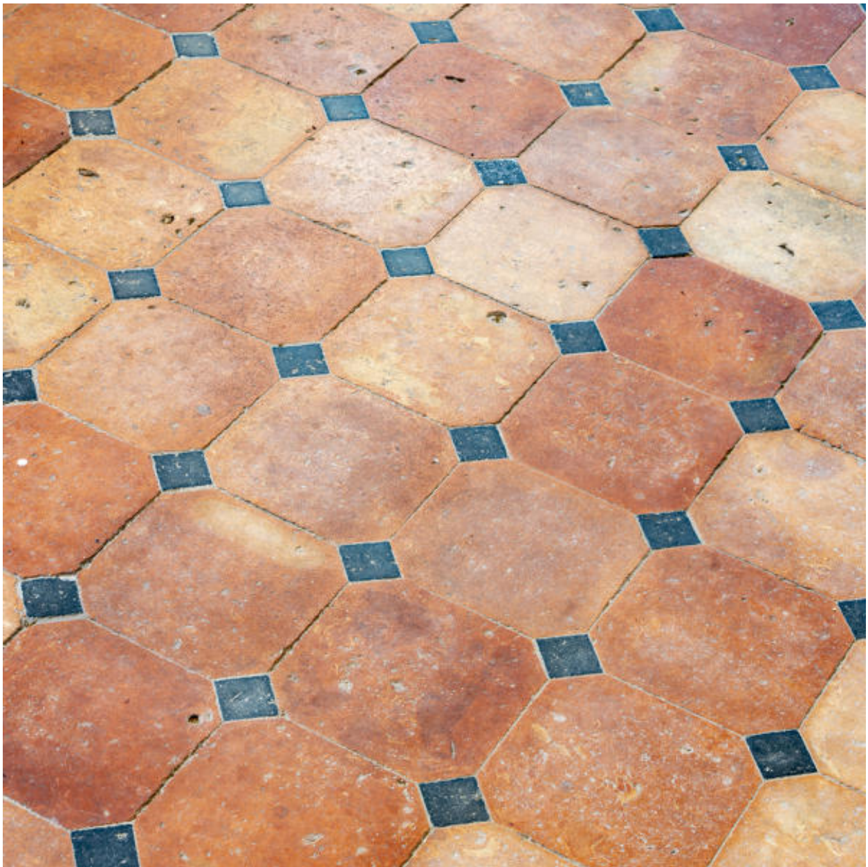
Dallage à cabochon de la chapelle sud de l'église Notre-Dame.
