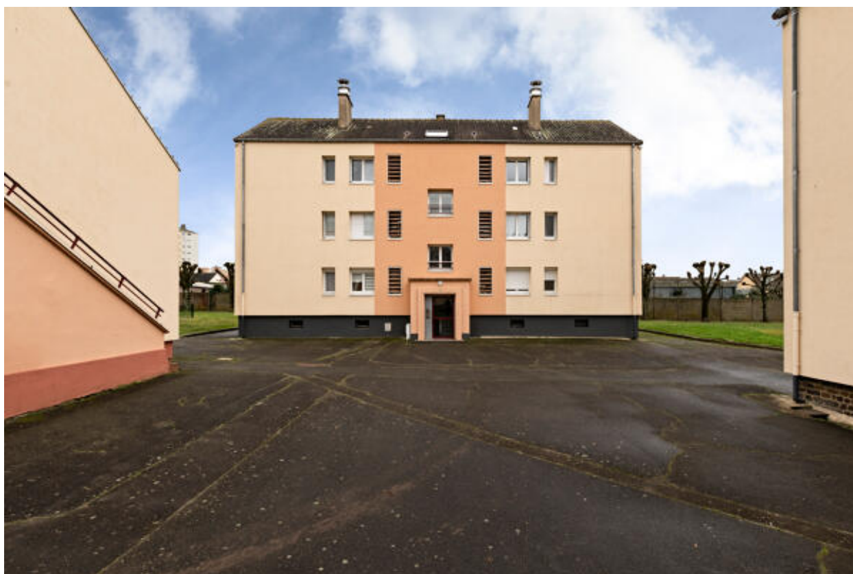
Vue d'un immeuble de type B de la cité Joly.
