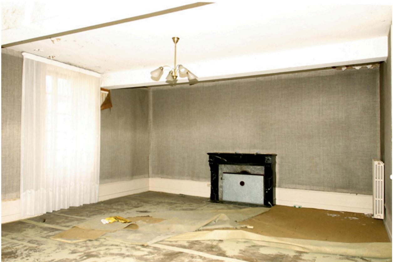
Cheminée à l'étage de l'aile sud, salle centrale.
