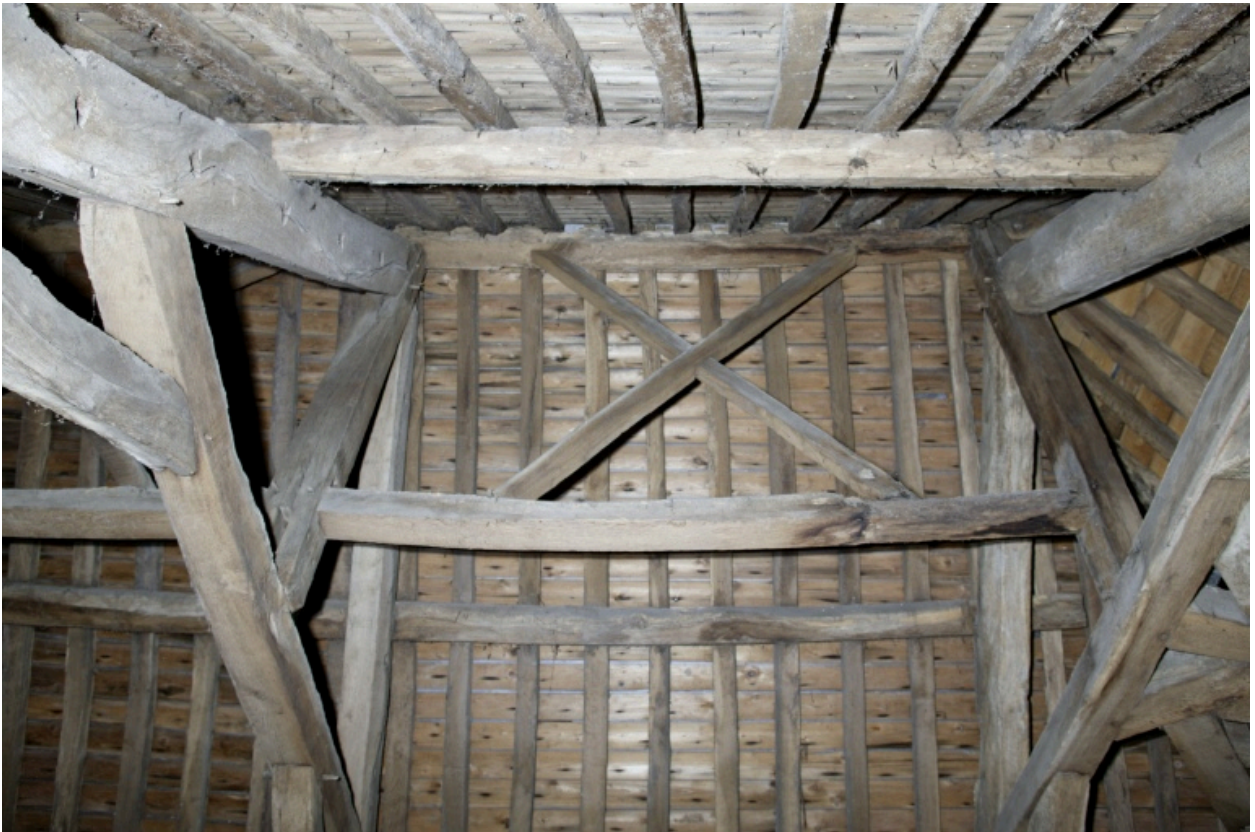
Vue de la charpente, détail d'une croix de Saint-André.
