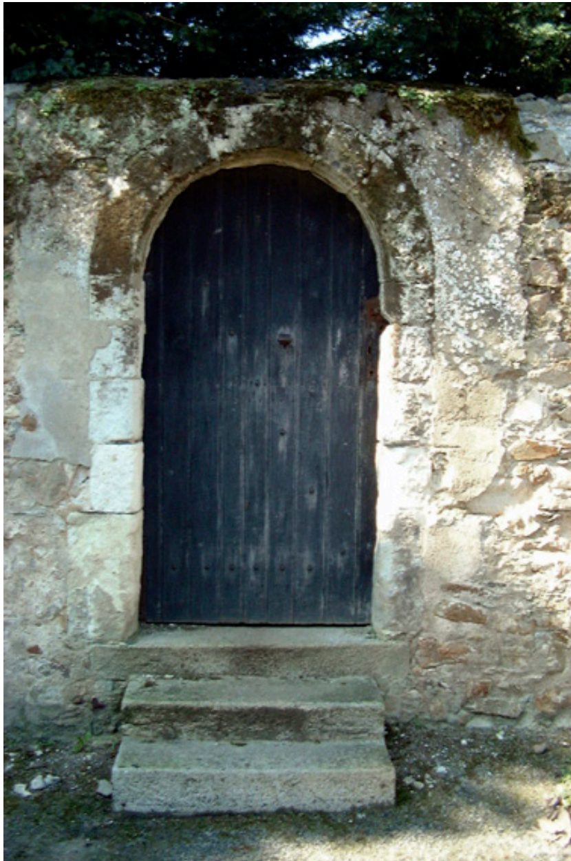
Porte d'accès au jardin.
