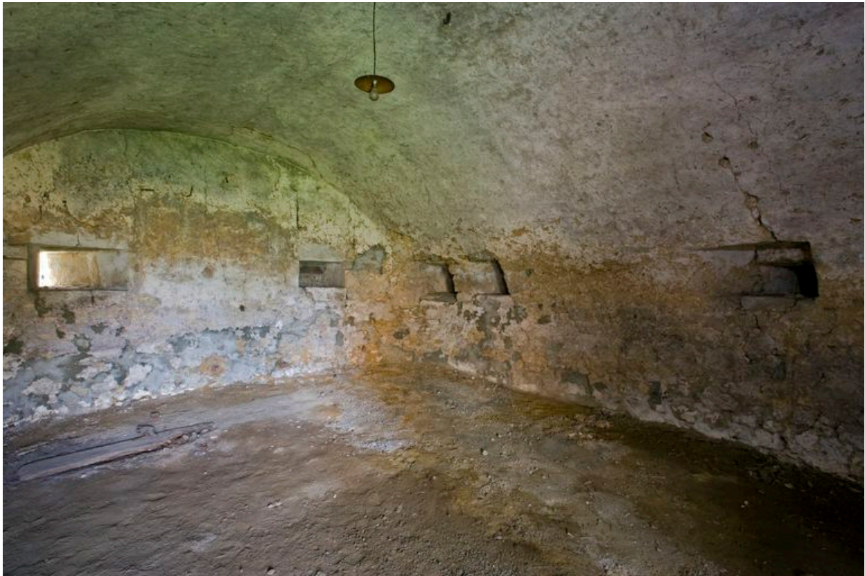
Vue intérieure du rez-de-chaussée du colombier
