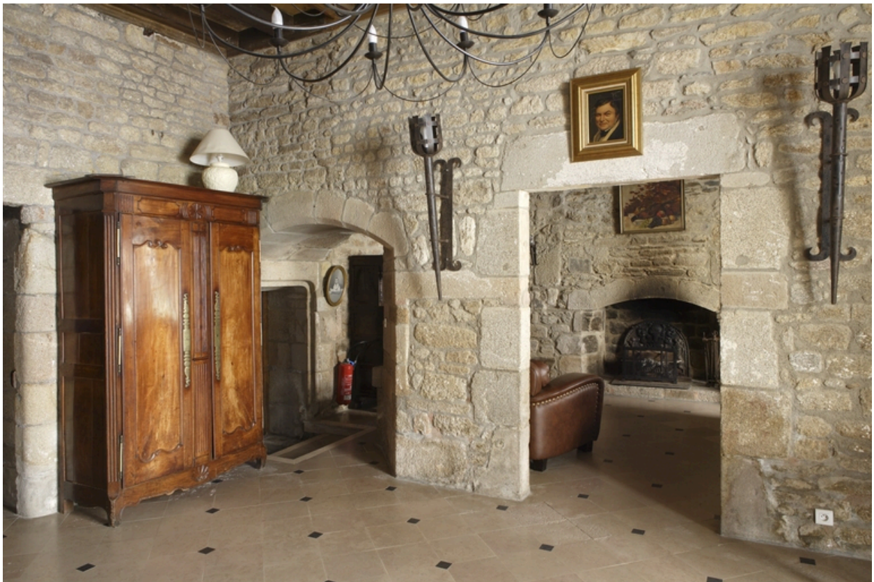
Logis. Aile est. Salle. Rez-de-chaussée. Mur de refend (?).
