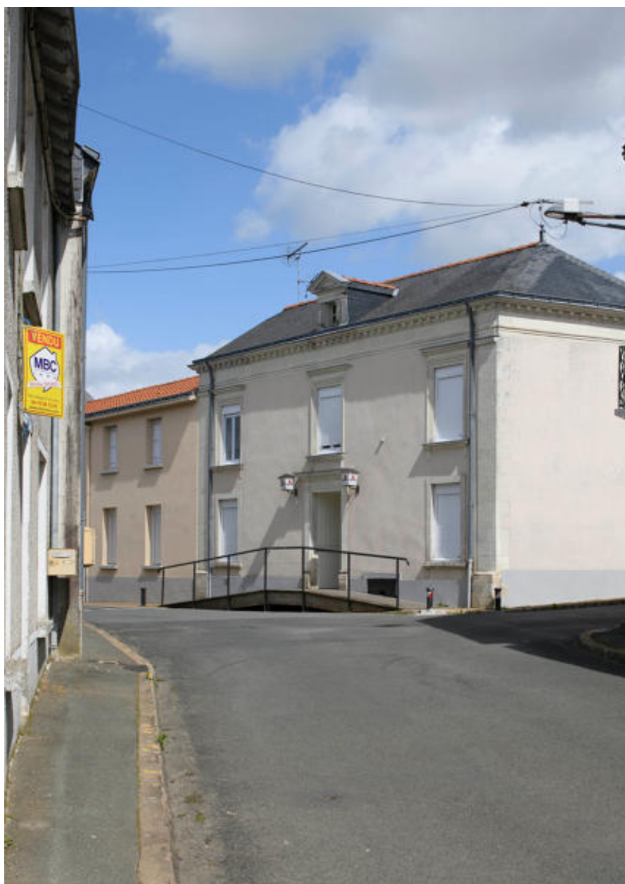
Maison, 11 rue de la Mairie.
