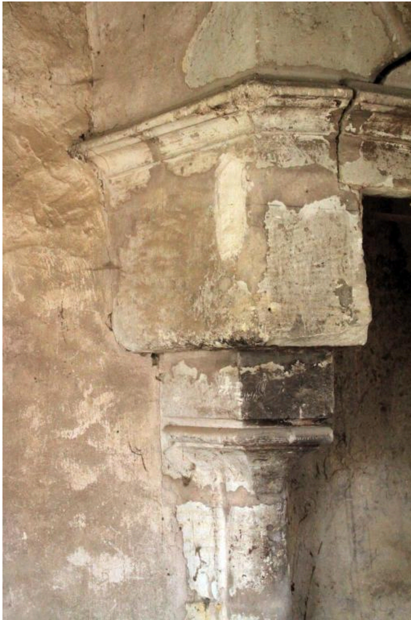
Cheminée de la grande salle : piédroit gauche et linteau.
