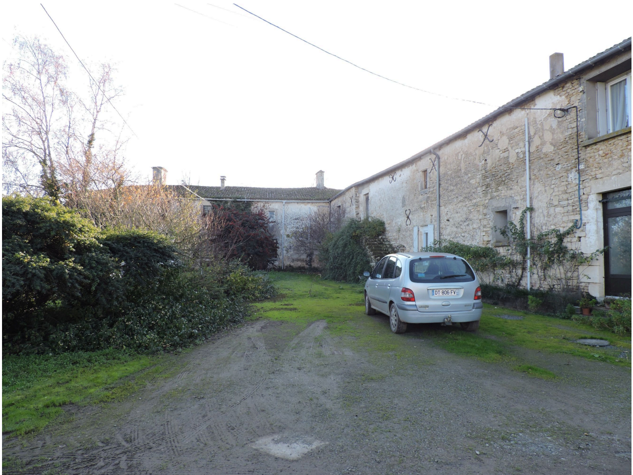
La cour nord vue depuis le nord, avec l'aile de communs à droite et le logis à l'arrière-plan.
