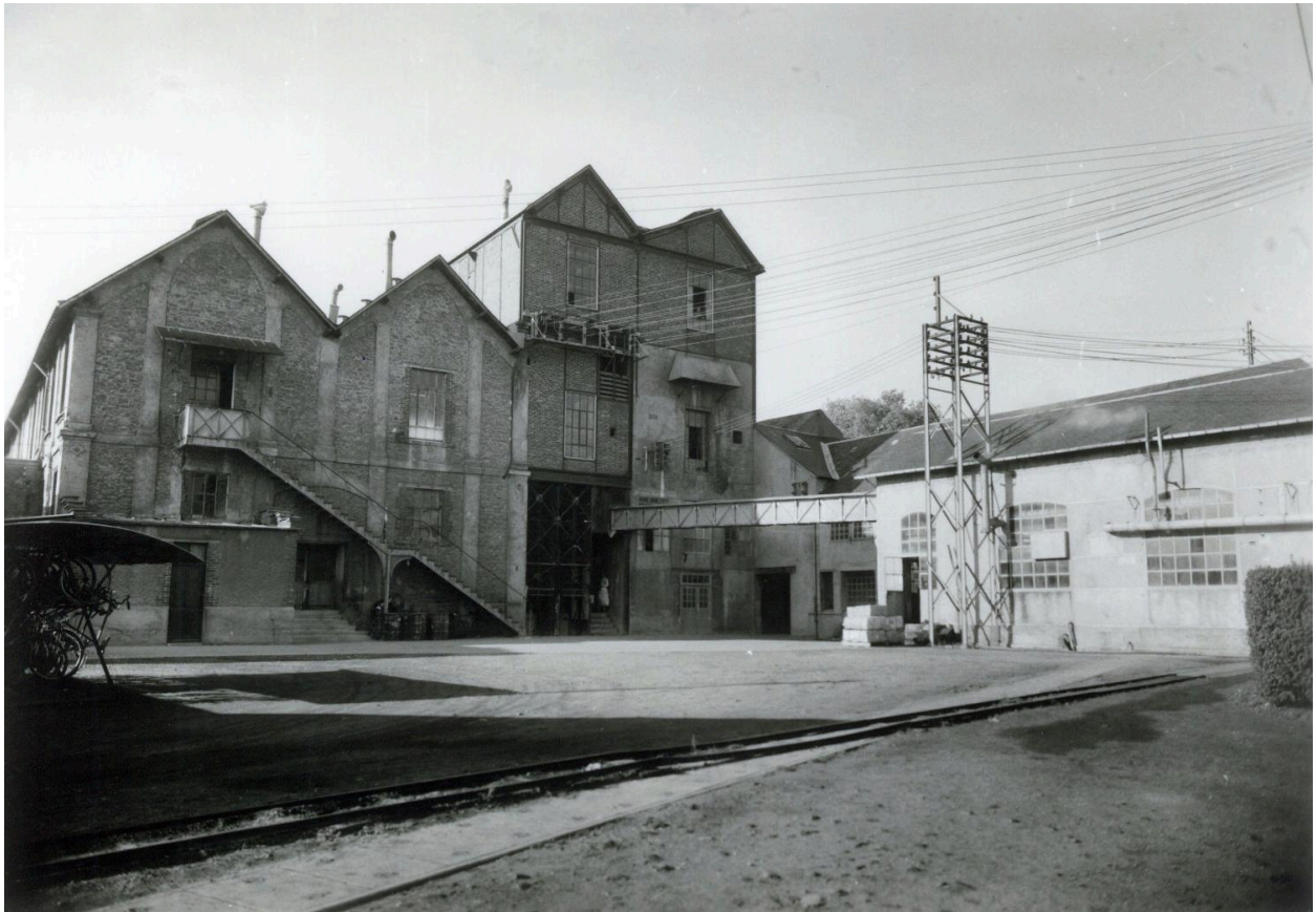
Vues de la papeterie de Bessé-sur-Braye au XXe siècle. Vue vers 1962 des élévations postérieures des ateliers de couchage de la limite des XIXe et XXe siècles.
