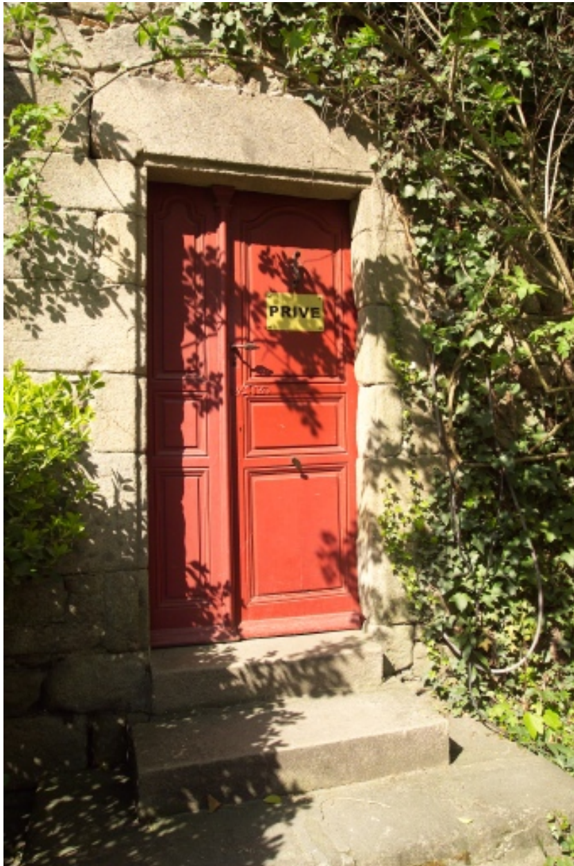
Détail des vantaux de la tour d'escalier.
