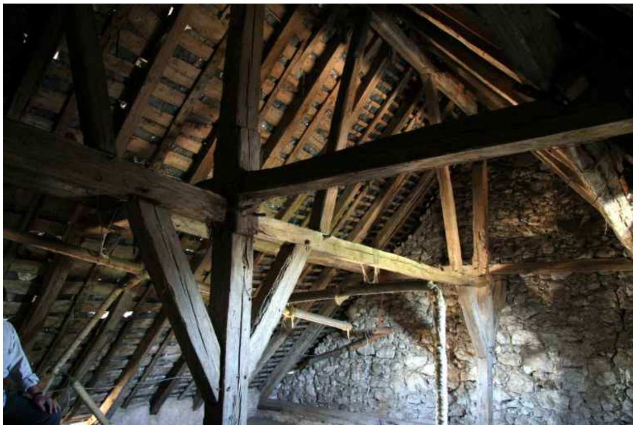
Charpente au dessus de la salle centrale.
