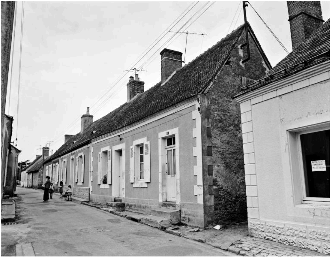
Des maisons du XIXe siècle, rue Fresnet, 1978.
