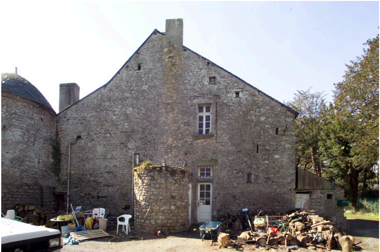
Élévation droite du logis.
