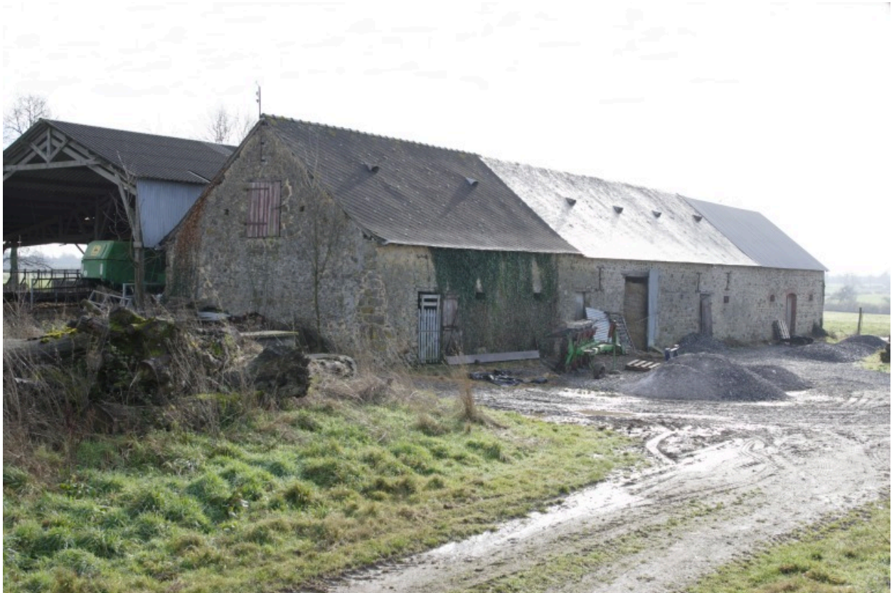
L'étable-grange vue depuis le nord-ouest.
