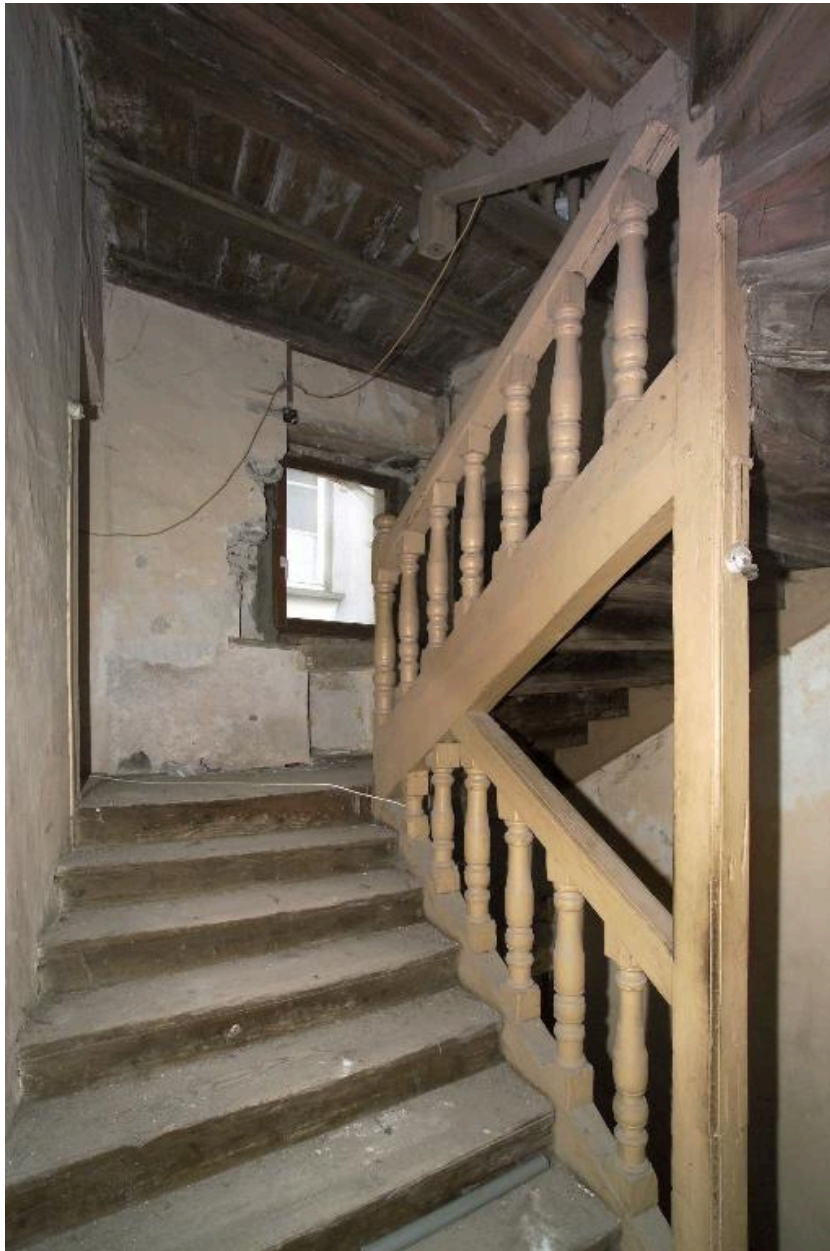
L'escalier articulant les deux corps de bâtiment, vue prise du premier étage.
