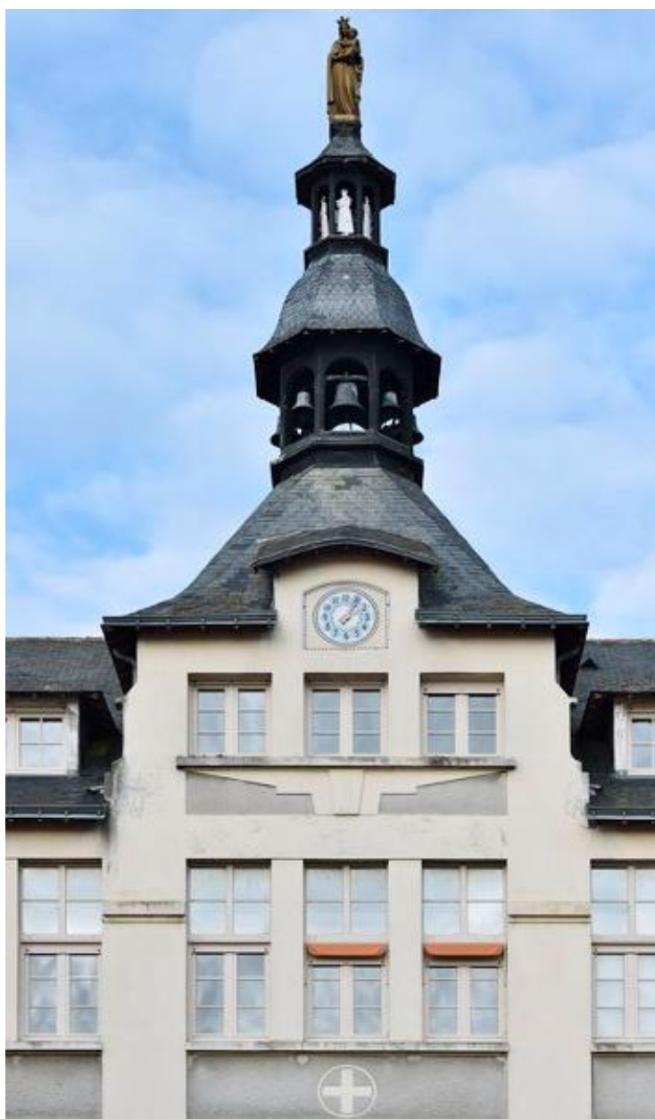
Façade centrale et campanile.
