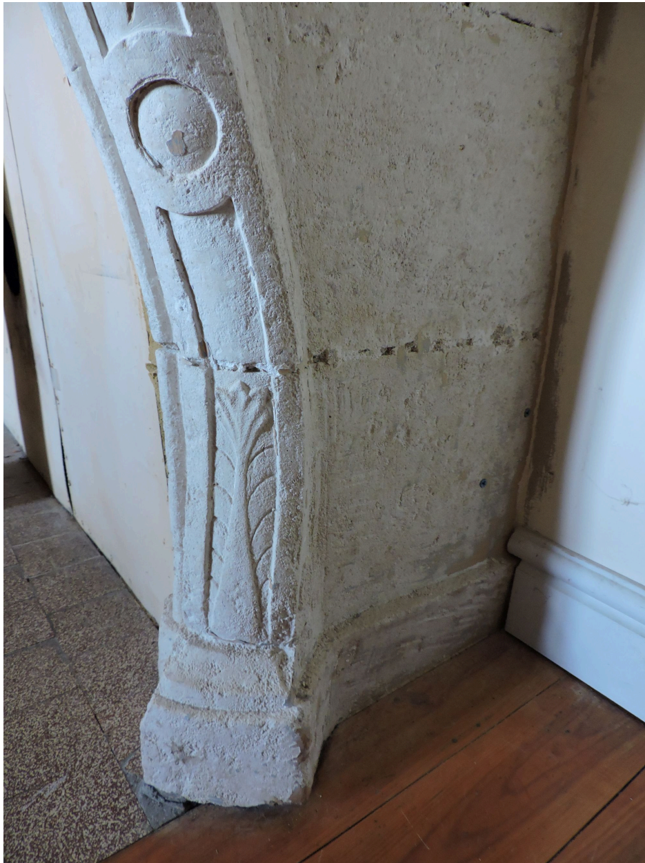
Détail du décor sculpté de la cheminée à l'étage : jambage galbé, à motifs géométriques et végétaux.
