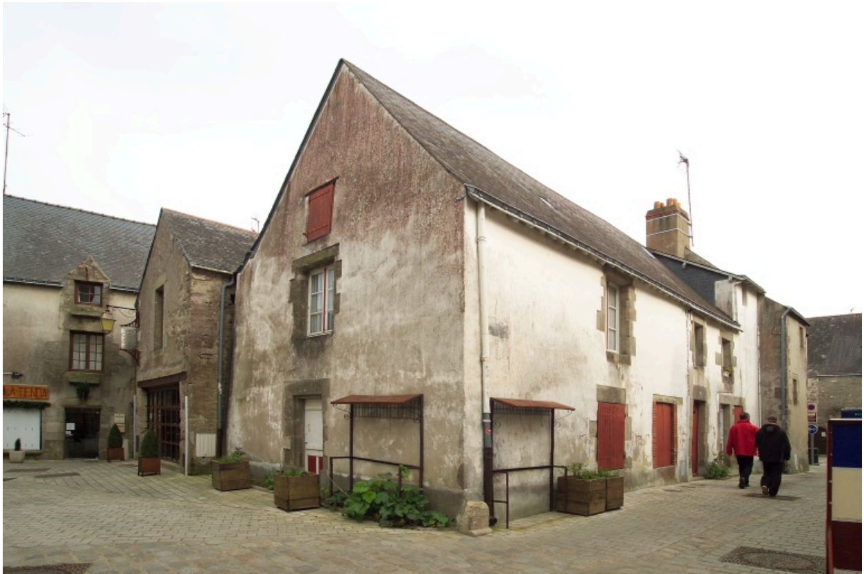
Vue générale vers le Sud-Est.
