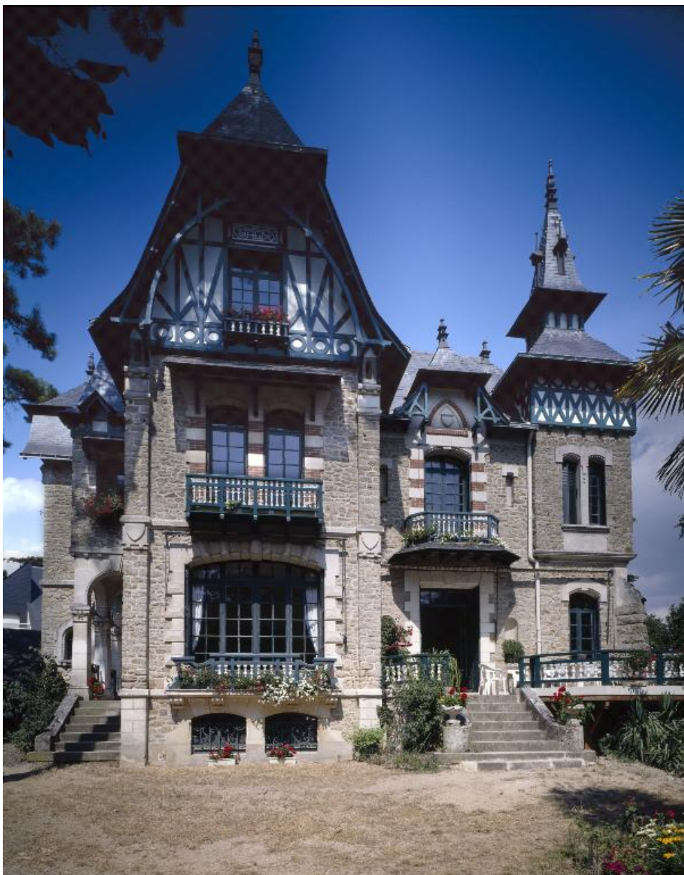
Façade sud de la villa Ker Louisic.
