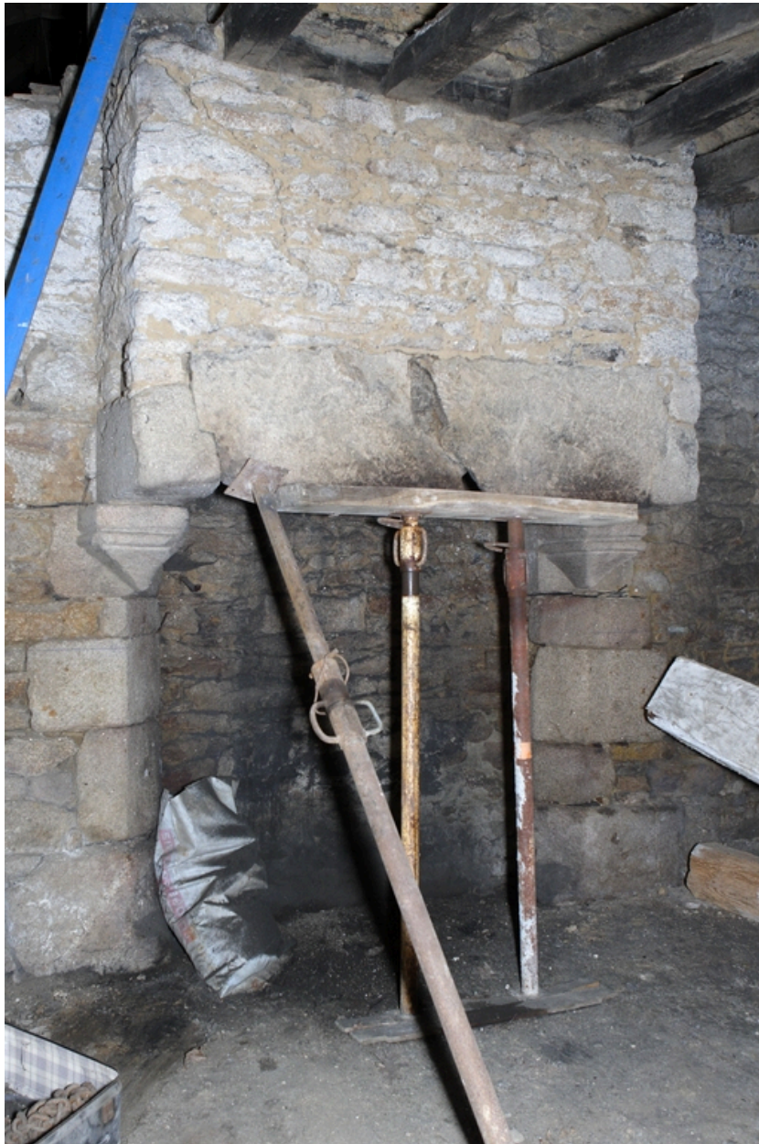
Bâtiment ouest. Détail de la cheminée.
