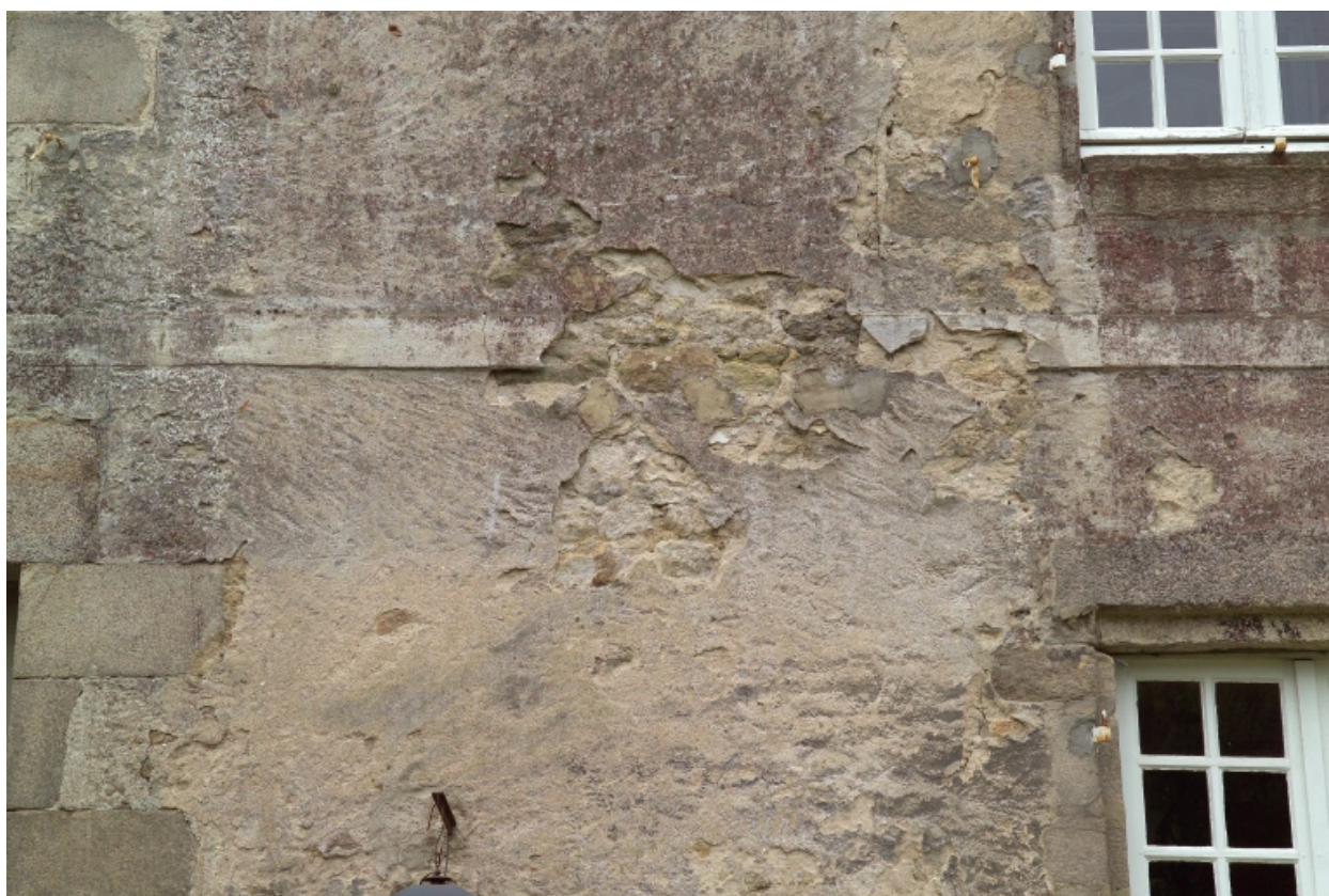
Hôtel XVIIIe siècle détail de la mise en œuvre et du faux bandeau.
