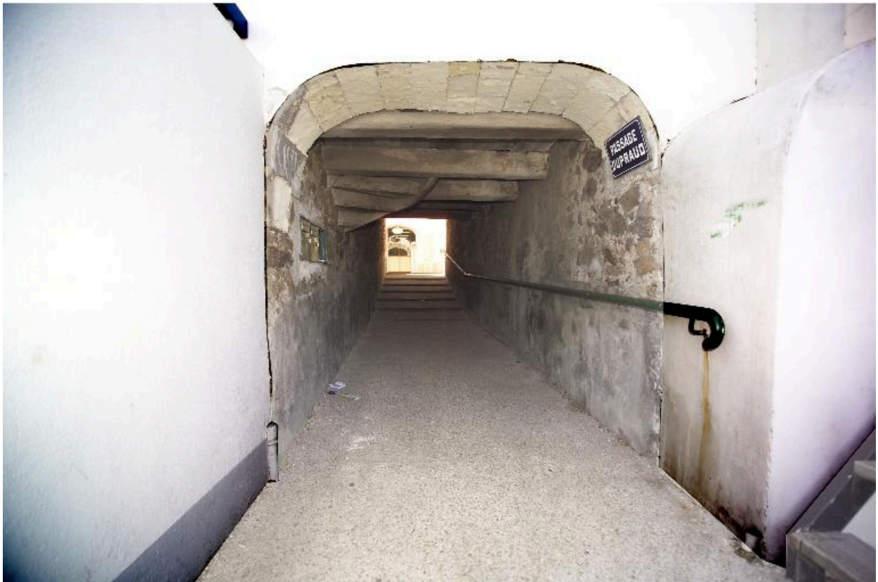
Le passage du Praud vu depuis le quai vers la rue.
