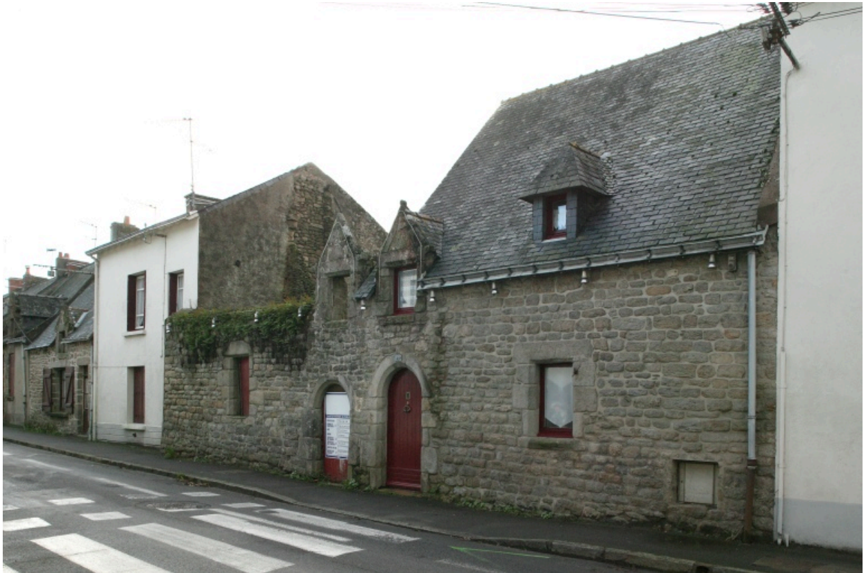
Vue de la façade sur rue.
