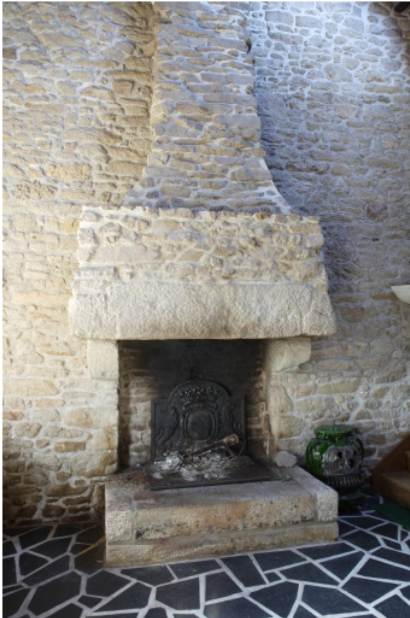
Détail de la cheminée du premier logement (2 chemin des Perrières).
