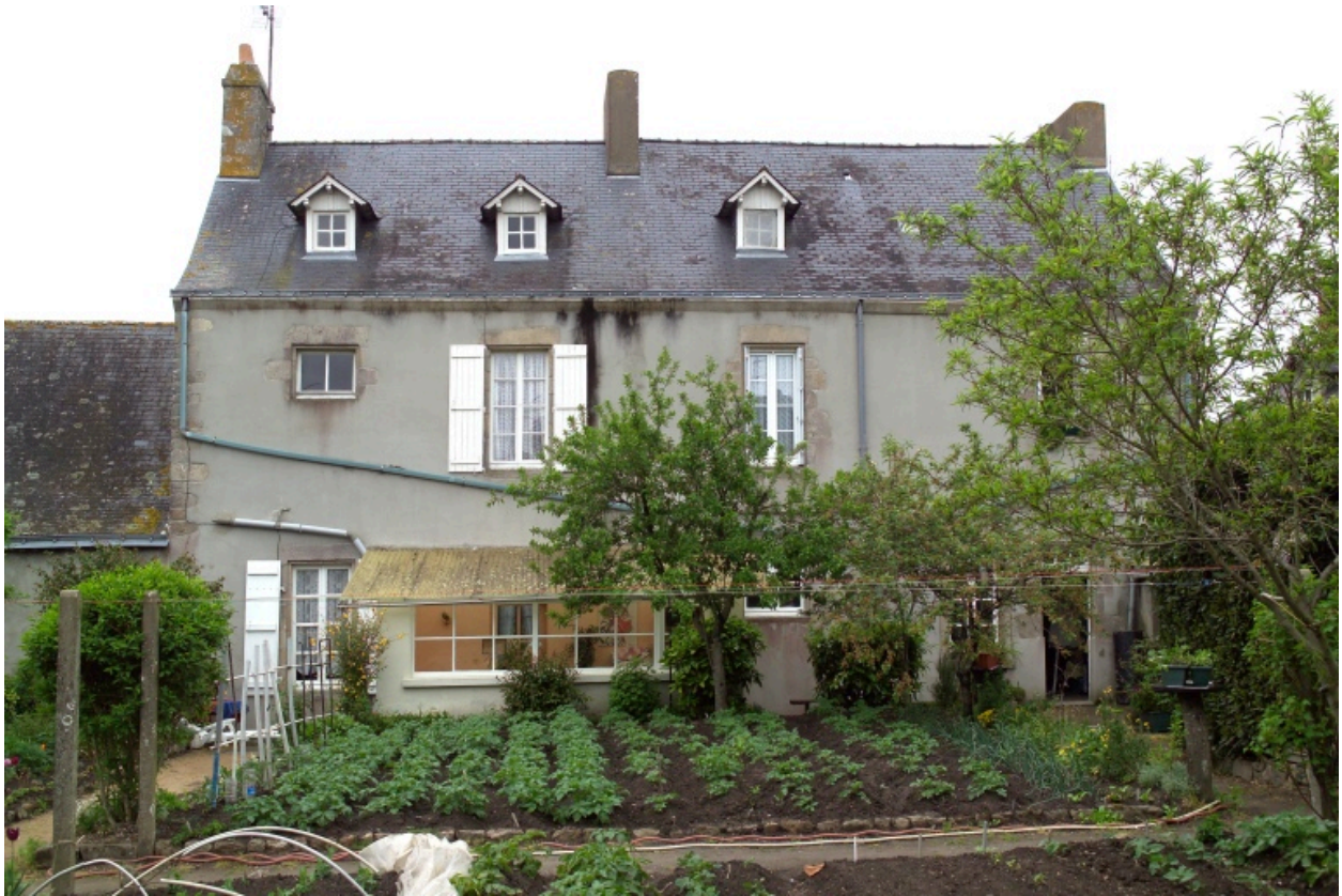
Vue de la façade arrière de la partie nord.
