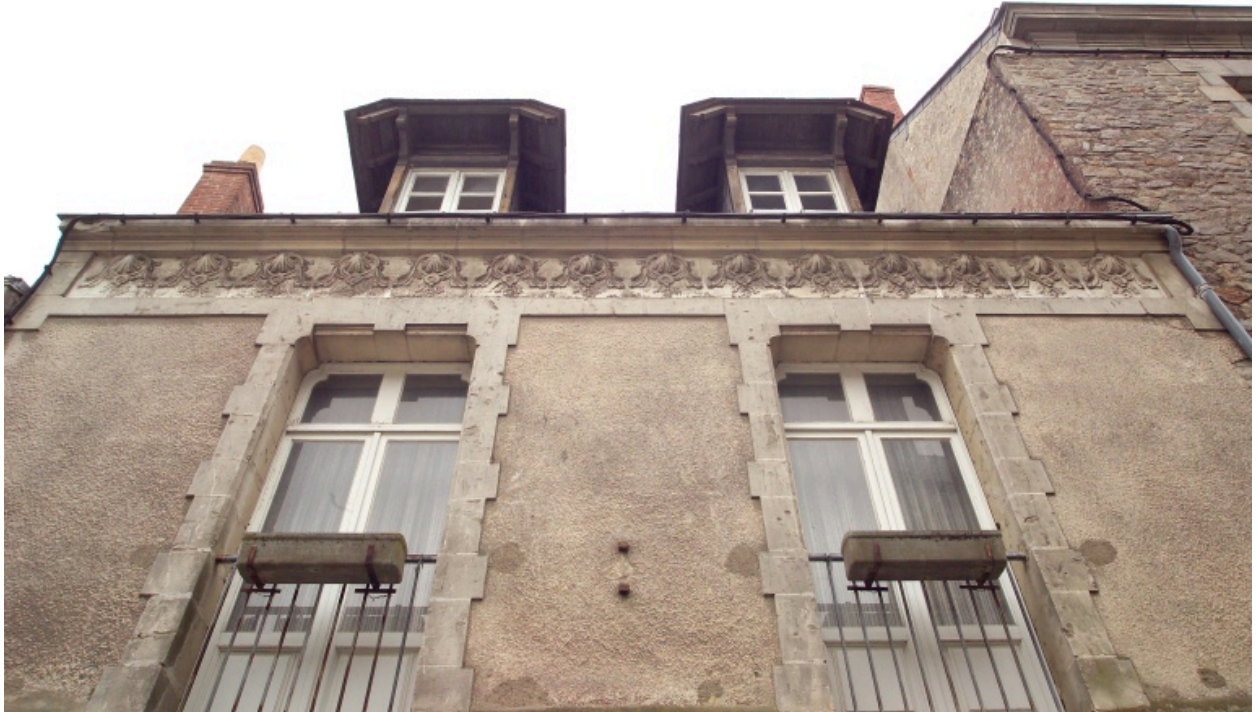
Façade sur rue, détail.
