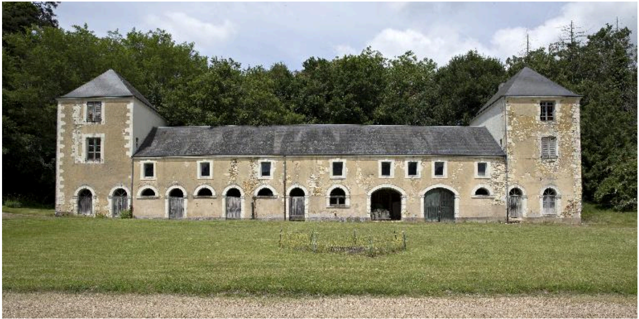
Les communs (écuries) en fond de cour, face au corps de logis.
