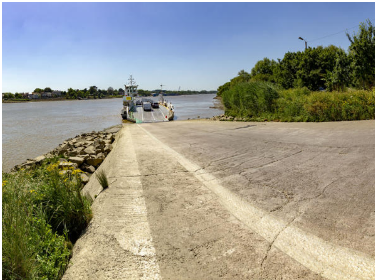
Vue de la cale aval de l'embarcadère.
