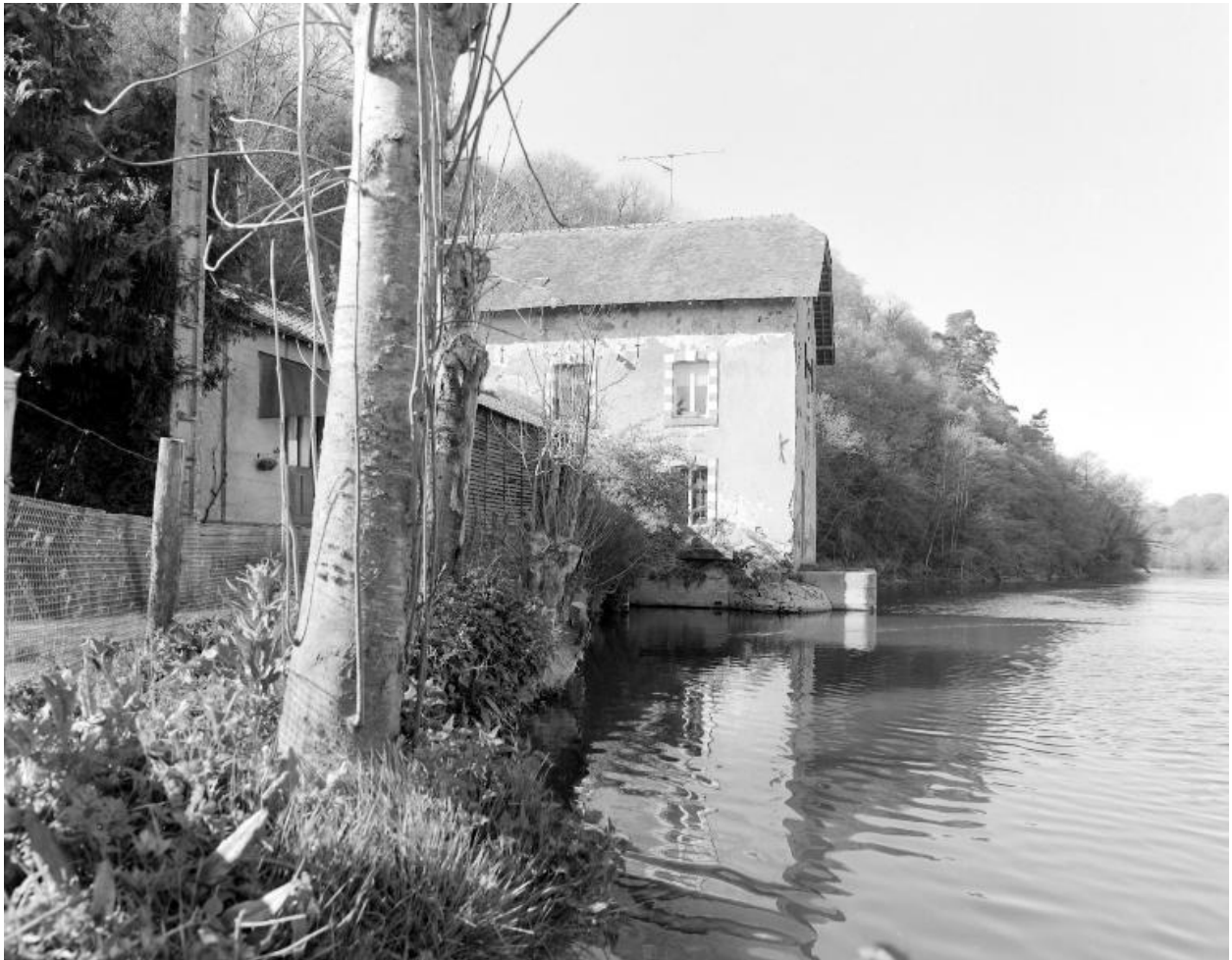
La façade nord-est (amont).
