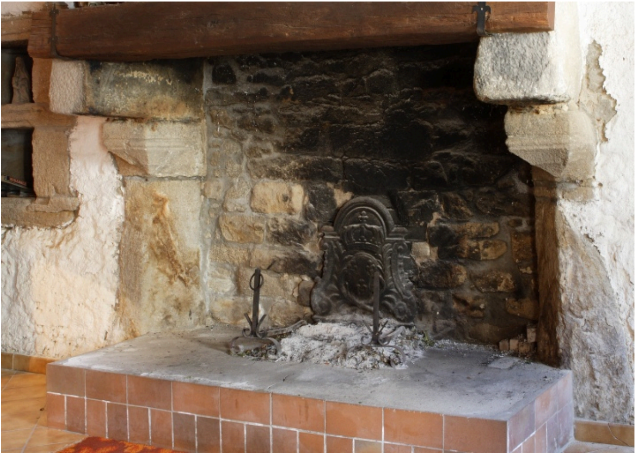
Vue de la cheminée (6 rue de l'Aha).
