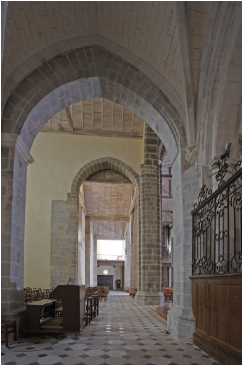
Collatéral droit restauré : vue d'ensemble vers le sud.
