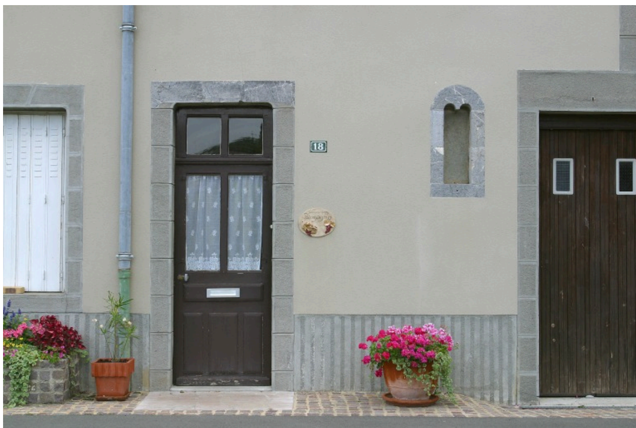
Détail de la façade principale : partie centrale du rez-de-chaussée.
