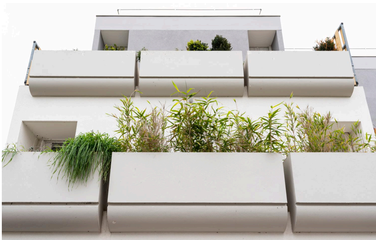
Vue des gradins en façade principale d'un immeuble.
