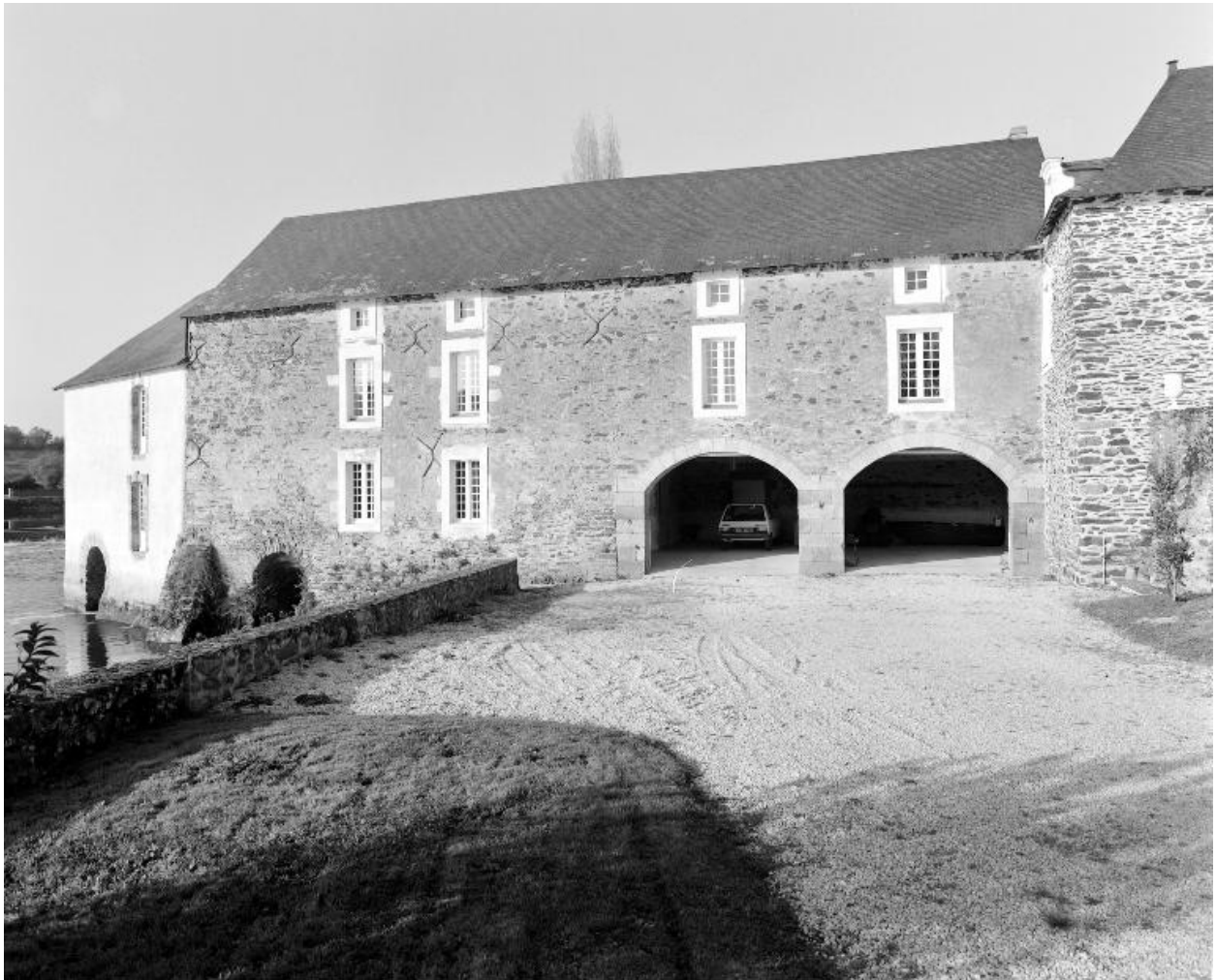
Façade sud du moulin.
