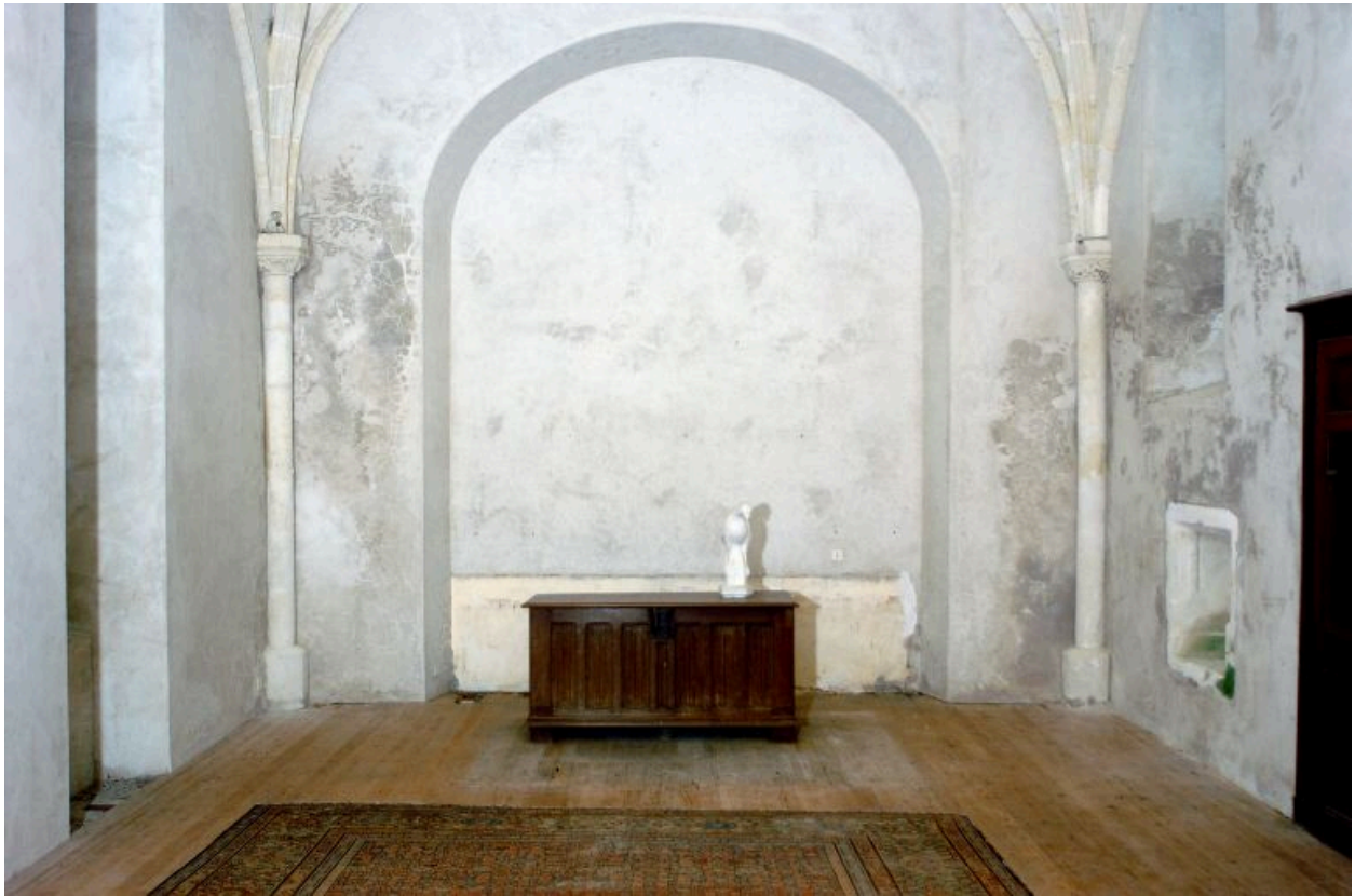
La chapelle : nef à deux travées.
