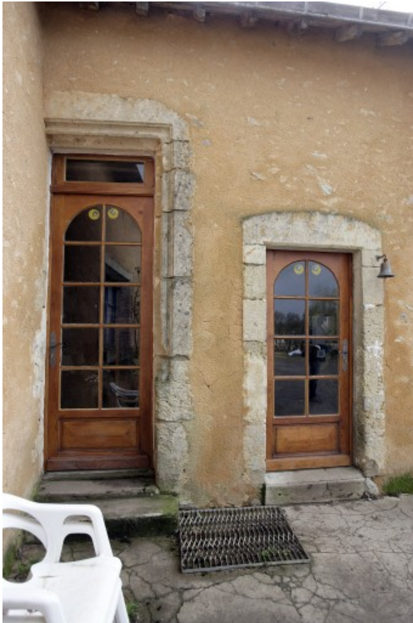
Détail de l'élévation ouest du logis : la porte et la fenêtre.
