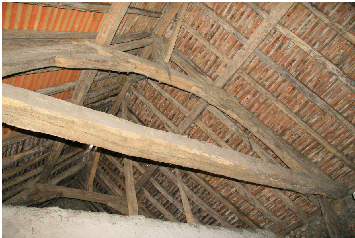
La charpente de la maison.
