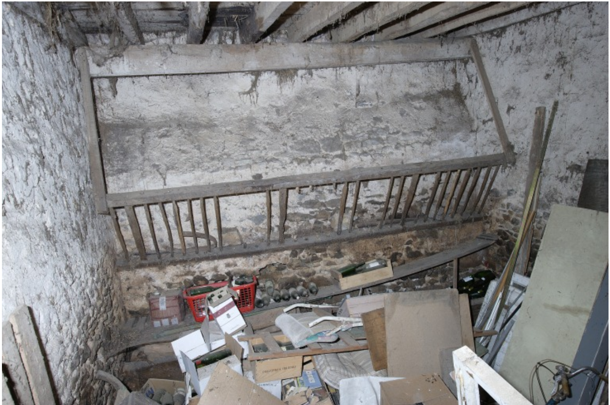
La première étable, pièce centrale : mur nord.
