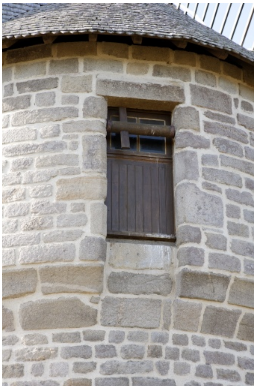
Cage, côté est. Détail de l'une des deux portes haute et du treuil.
