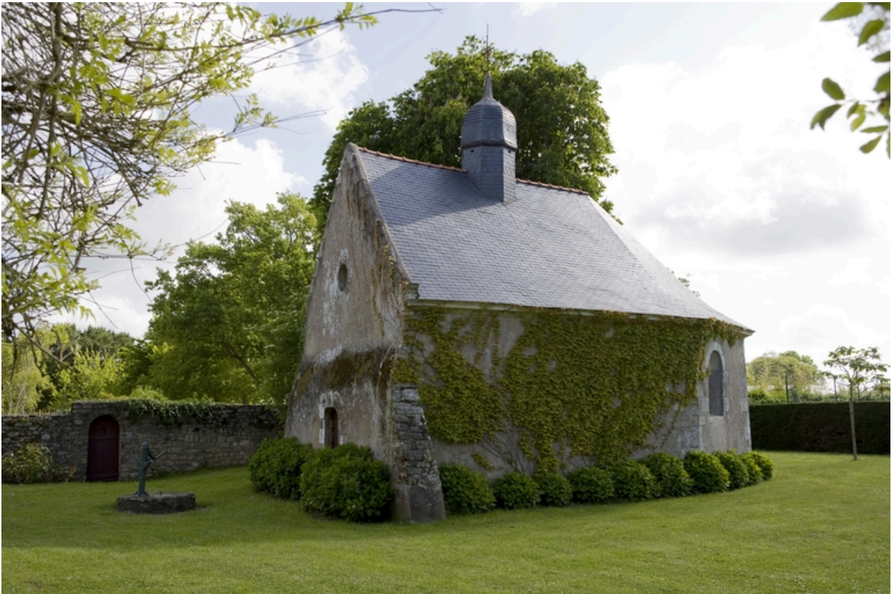
Chapelle. Vue d'ensemble depuis le sud.
