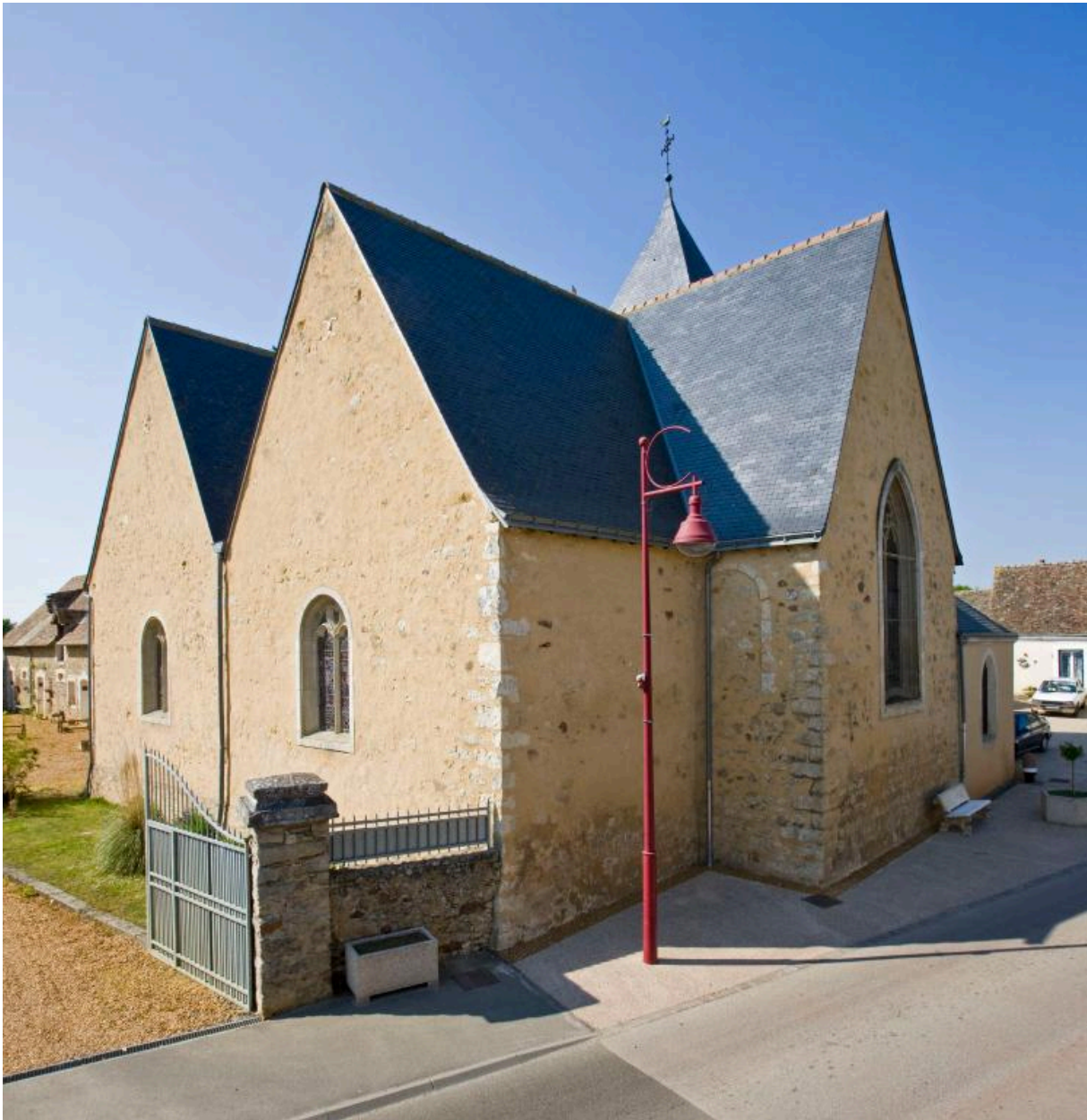
Choeur et bas-côté sud, vus depuis le sud-est
