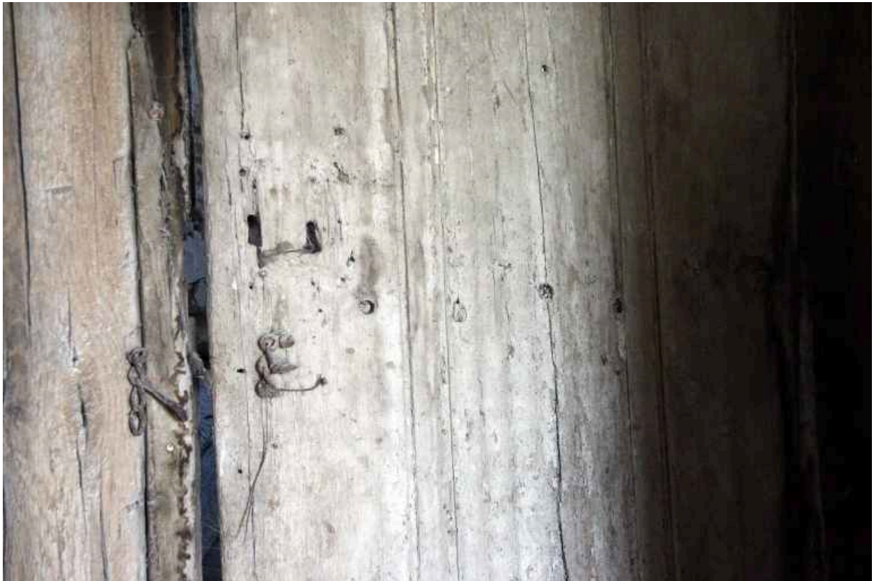
Cage d'escalier, porte du grenier : serrure.
