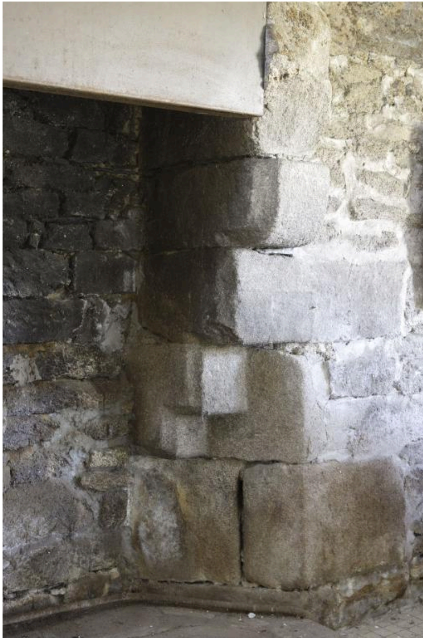
Aile est. Salle nord. Détail de la console de droite de la cheminée.
