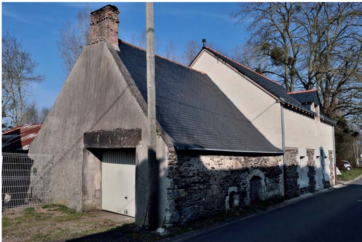
Maison construite sous la levée (RD 132 ; levée Ligérienne)
