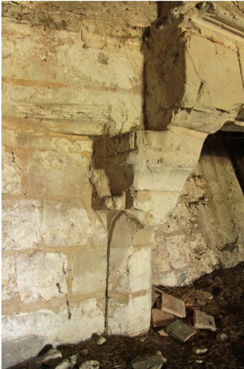
Le logis, comble, cheminée : piédroit gauche.
