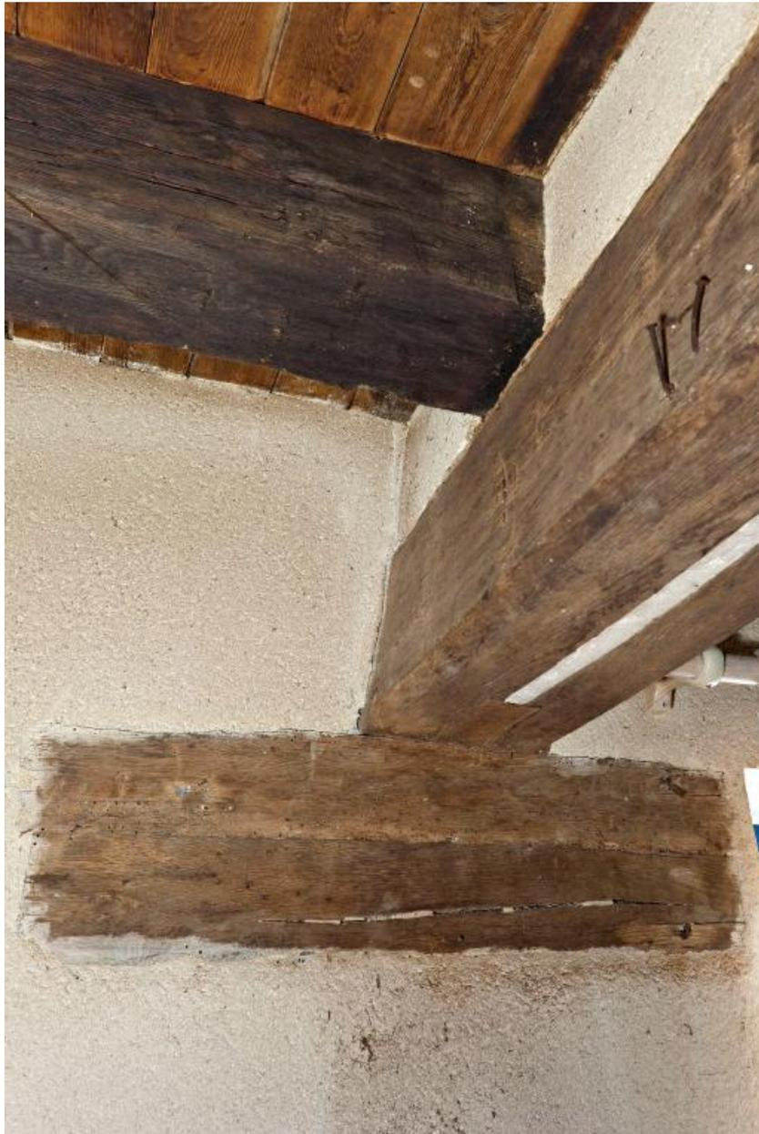
Chambre à feu est : vestiges de pan de bois maçonné, sous la grosse poutre.
