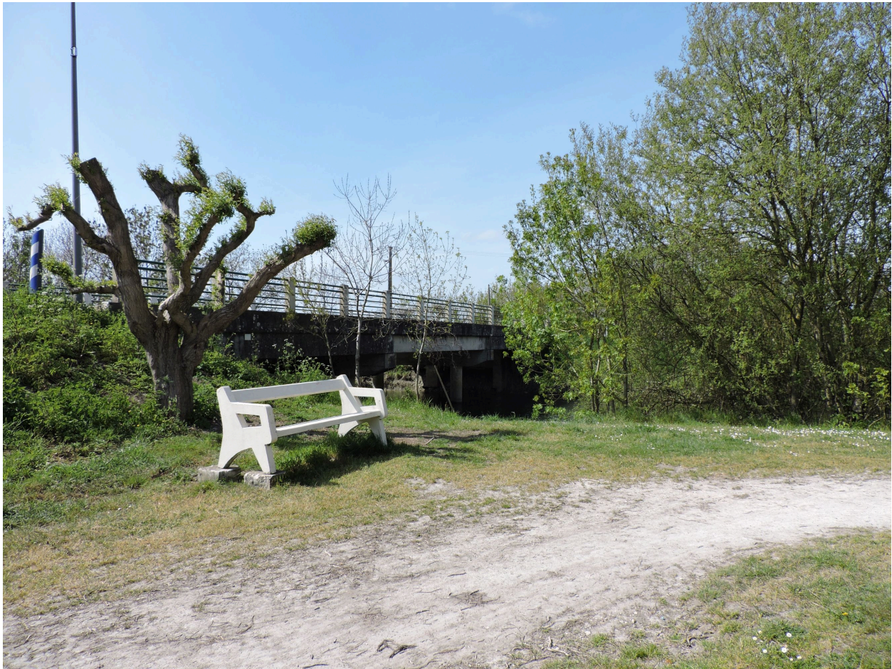
L'emplacement du port, comblé, à l'est du pont, vu depuis le sud-est.
