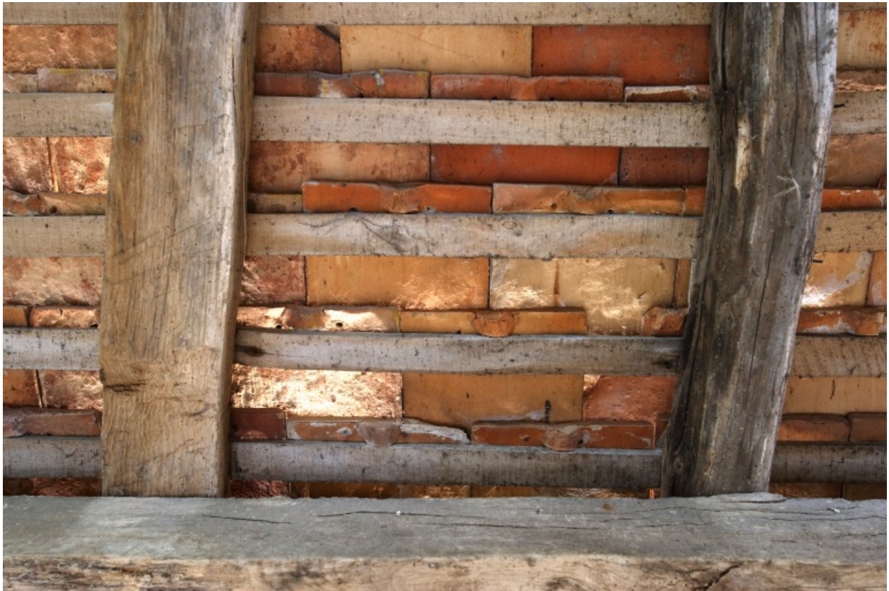
Le logis-étable ouest, comble de la partie logis : détail de la couverture vue de dessous.
